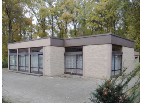
Das Thomashaus, Baujahr 1973/74
