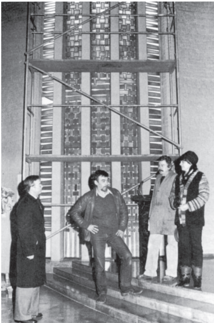
Abb. 26: Einbau der Altarraum-Fenster in der Thomaskirche
